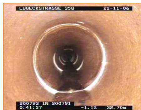
Bild 4: Intakter Steinzeugkanal
