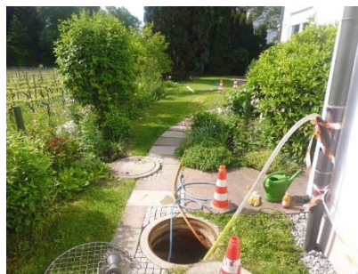
Prüfung am Schacht mit Füllschlauch
