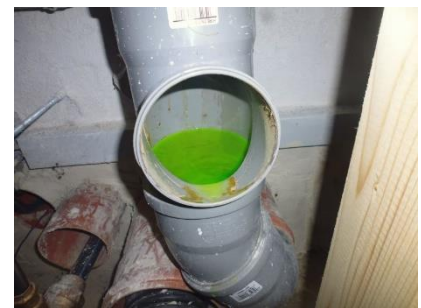
Wasserstand – Kontrollöffnung im Keller
