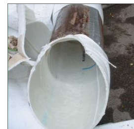
Bild 8: Fertiges „Rohr im Rohr“
