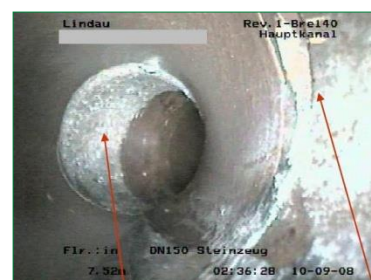
Bild 7a: Sekundärschaden
